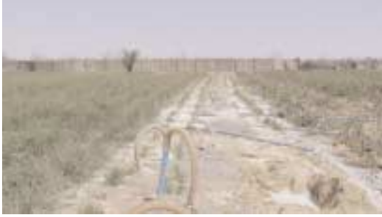
شفط المياه لتركيب شبكة الصرف
